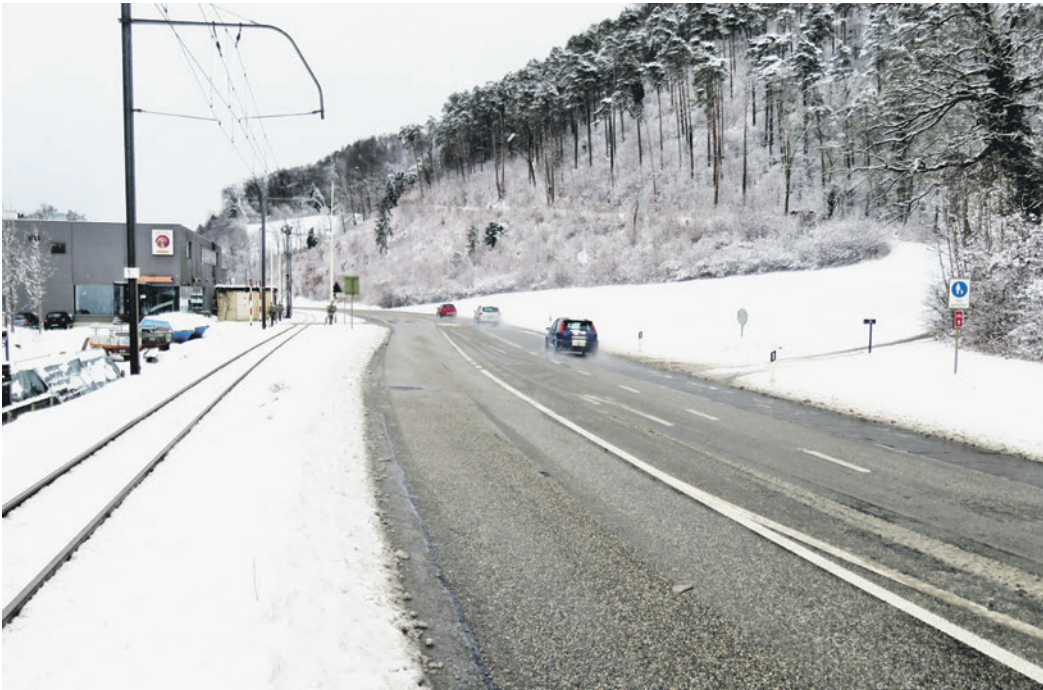
Die Hauptstrasse in Hölstein: Rechts die vorgesehene Zufahrt zur Deponie «Baholde», links der Bahnübergang zum Industriequartier «Bärenmatte».
